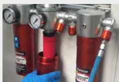
1. Desmonte el vaso del filtro
